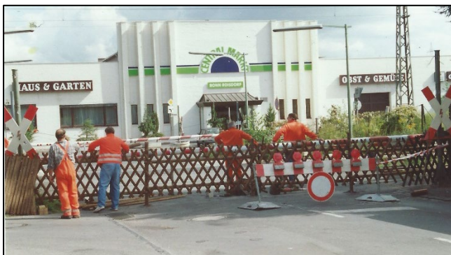
Sperrung des Bahnübergangs mit Fassade des Centralmarkts
